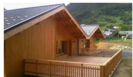
Photo de l'étage, après les travaux
