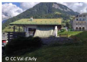
Photo de l'étage, avant les travaux
